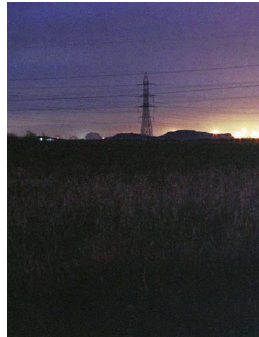
Contaminación lumínica generada por el pésimo alumbrado del enlace entre la M-50 y la A-3 en Madrid, consistente en la instalación de focos a gran altura. Foto: Francisco Pujol.
