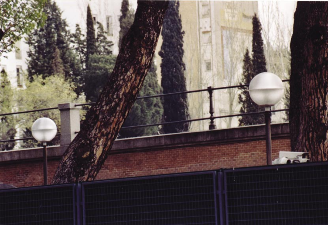
El globo con grupo óptico posee un reflector aluminizado que recoge buena parte de la luz que antes iba al cielo. Es una alternativa aceptable al globo ineficiente y contaminante. Foto: Francisco Pujol.
